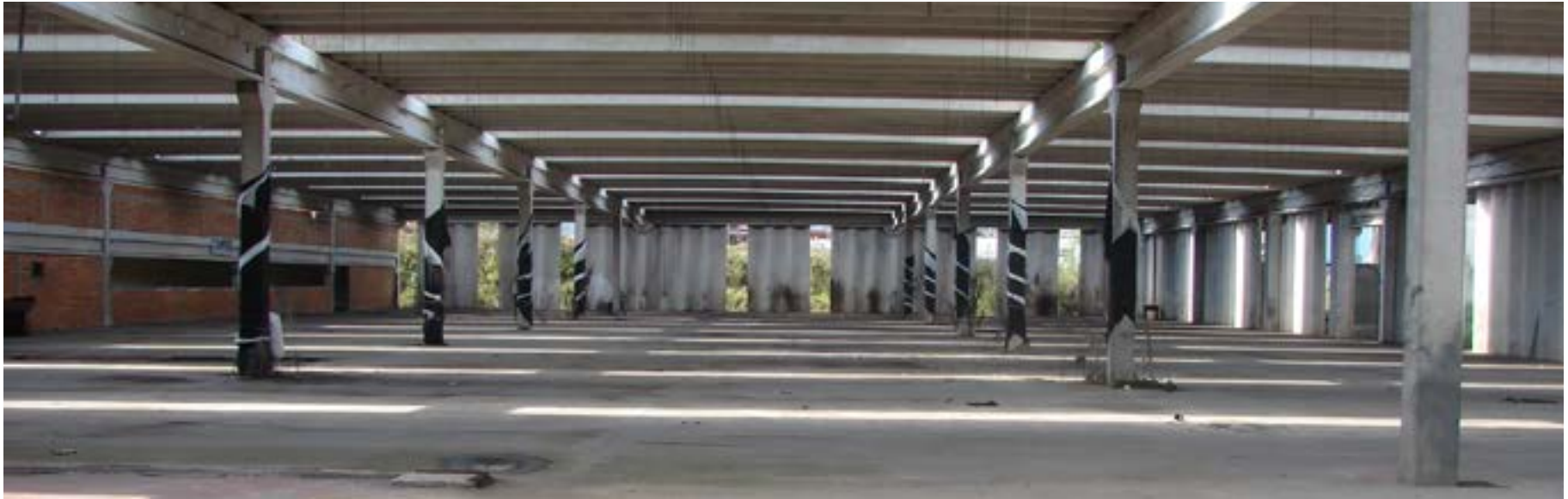
Área de 12 mil metros cuadrados que se encontraba abandonada y necesitaba ser recuperada en su totalidad
